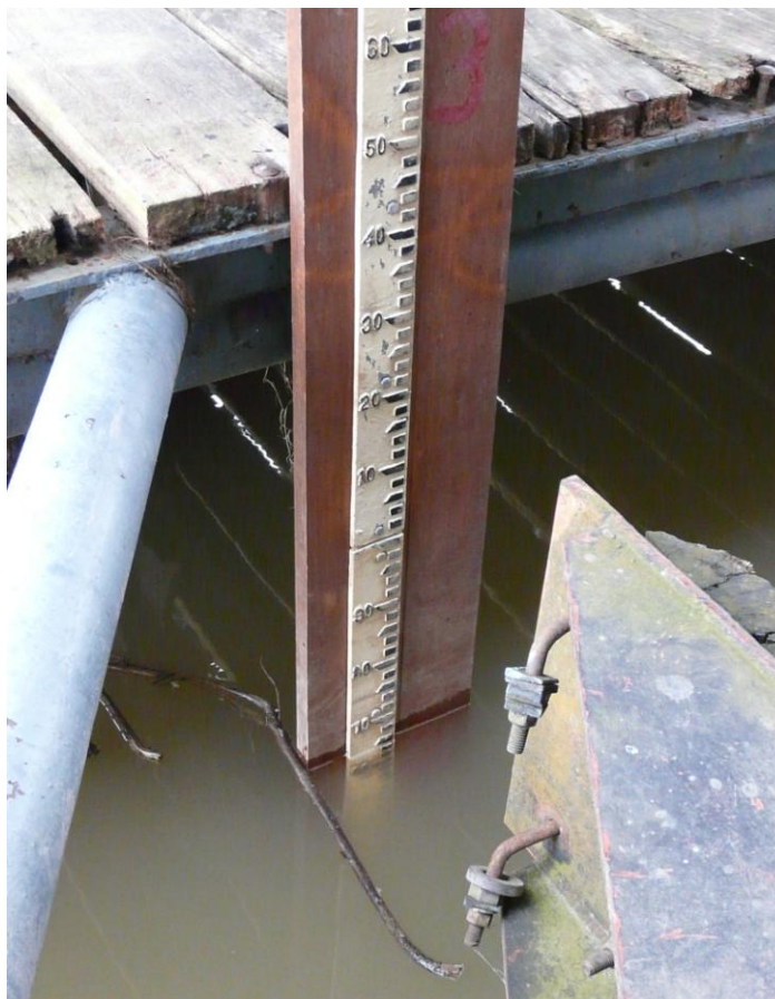
Fotografía 09.- Limnómetro instalado en la UIR Atalaya
