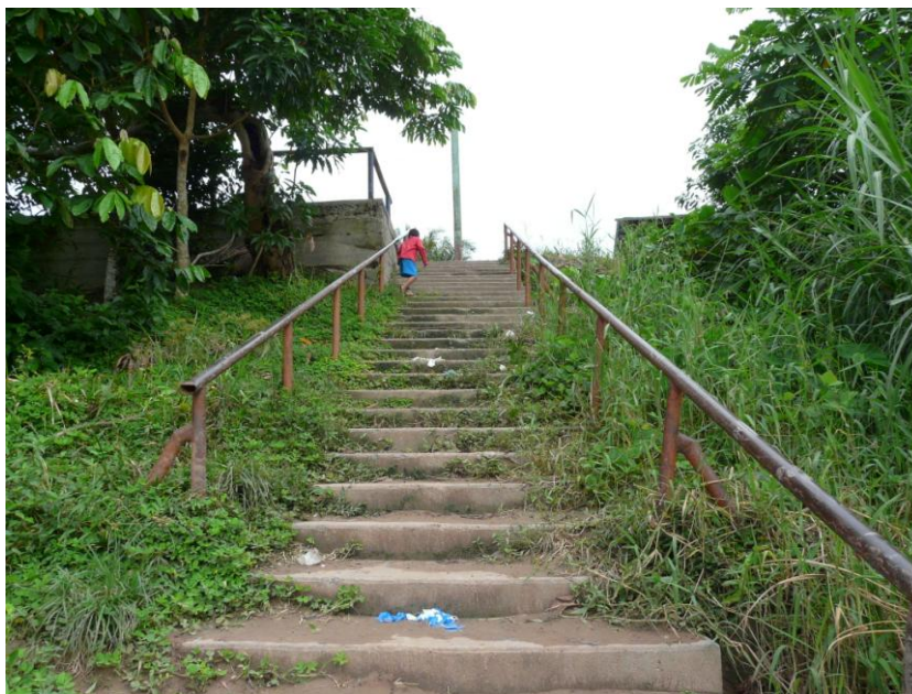
Fotografía 11.- Escalera empleada como limnómetro en CC.NN Sepahua
