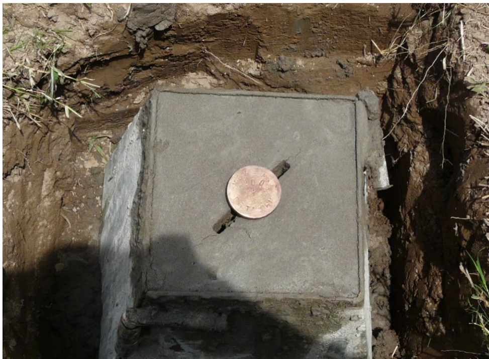
Fotografía 08.- Punto geodésico en proceso de construcción
